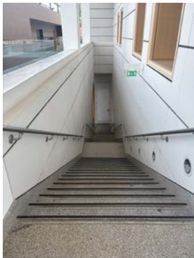
Escalier étage 1 menant à l'étage 0
