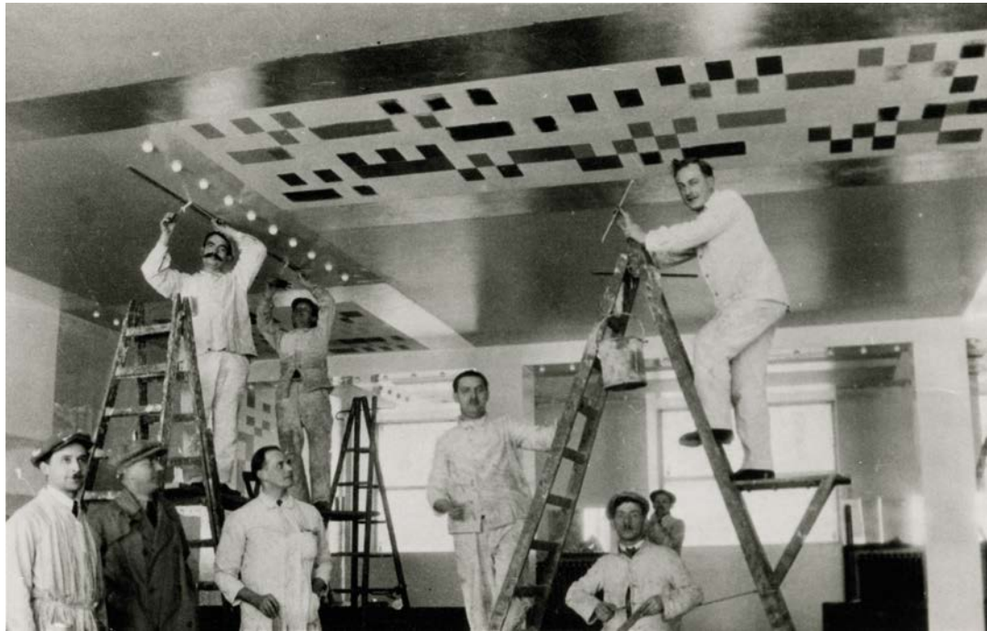
Travaux de peinture en 1928, d'après le dessin de Sophie
