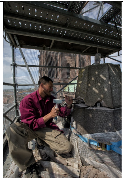
12. Artisans de la Fondation de l'Œuvre Notre-Dame sur le chantier du bras sud du transept, 2016. Fondation de l'Œuvre Notre-Dame. Photo : Jean-François Badias / Strasbourg Eurométropole
