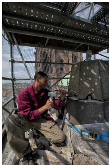
Craftsmen from the Fondation de l'Œuvre Notre-Dame on the work site of the south transept arm, 2016. Fondation de l'Œuvre Notre-Dame. Photo: Jean-François Badias / Strasbourg Eurométropole
