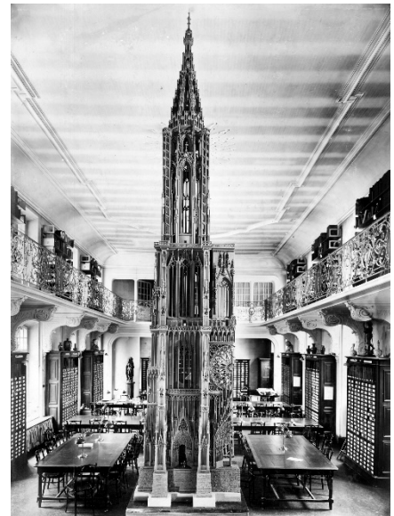
8. En 1914, lors du chantier de consolidation des fondations de la cathédrale, l'architecte Johann Knauth fait réaliser une grande maquette en plâtre de la moitié de la façade occidentale. Photo : Fondation de l'Œuvre Notre-Dame
